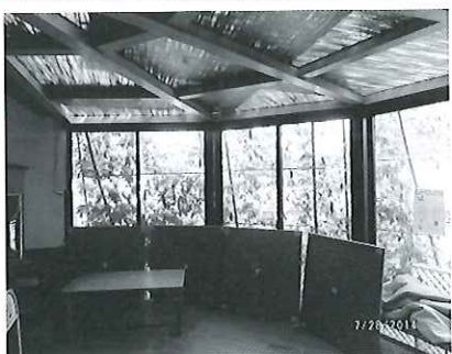
石部幼稚園多目的ホール
